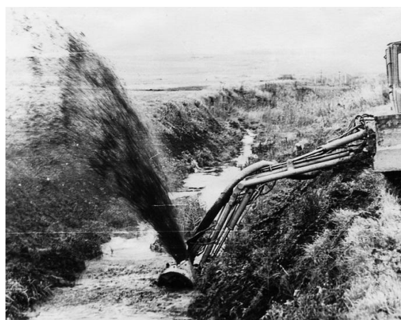
Рис. 2. - МРО, настроенное на работу в качестве фрез-метателя, и очистка им «сухого» канала
